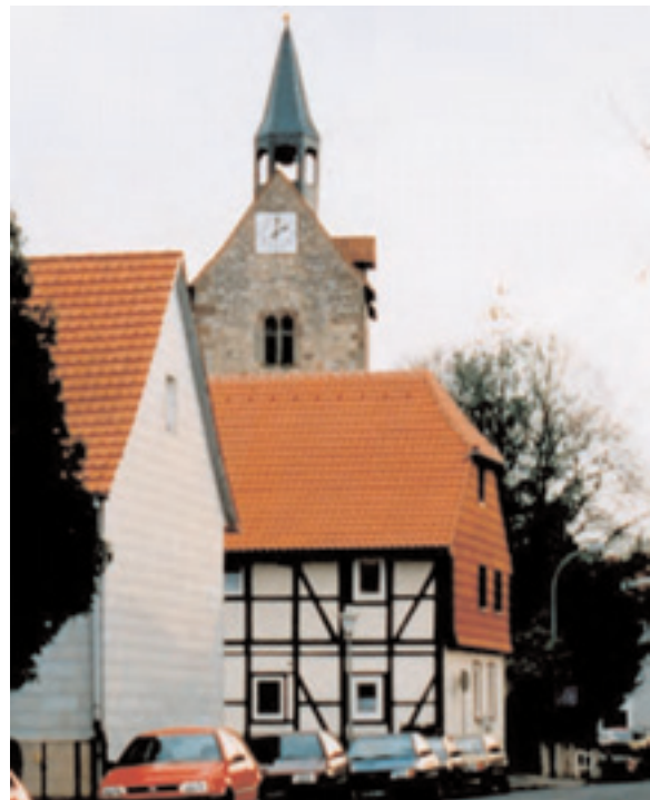
Petrikirche und ehemaliges Küsterhaus, heute Gemeindehaus
