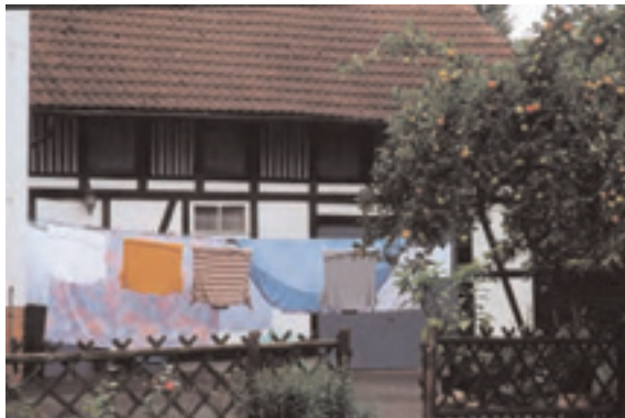
Ehemaliger Stallschuppen eines städtischen Mehrfamilienhauses um 1900; heute Garage und Abstellraum
