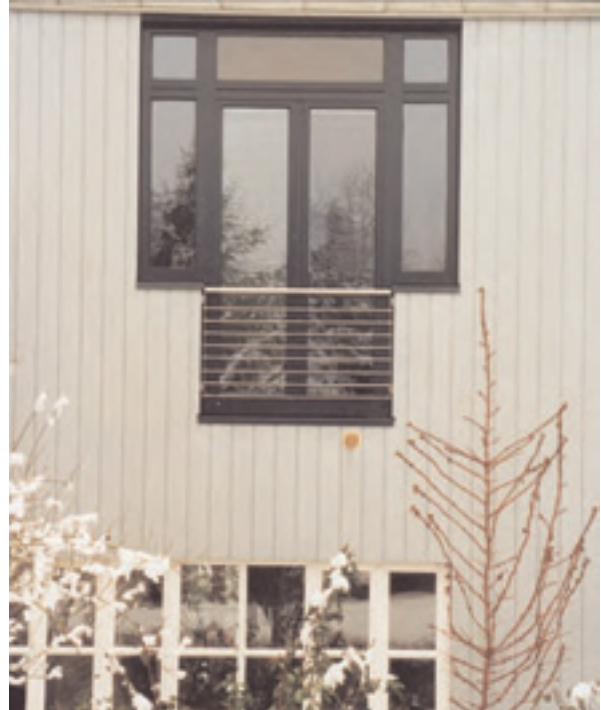
Unterteilte Fenster im Neubau: trotz großer Glasflächen keine „blinden Löcher“ in der Fassade
