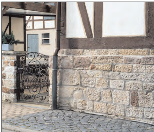
Bruchsteinmauerwerk erhalten und instandsetzen: förderfähig
