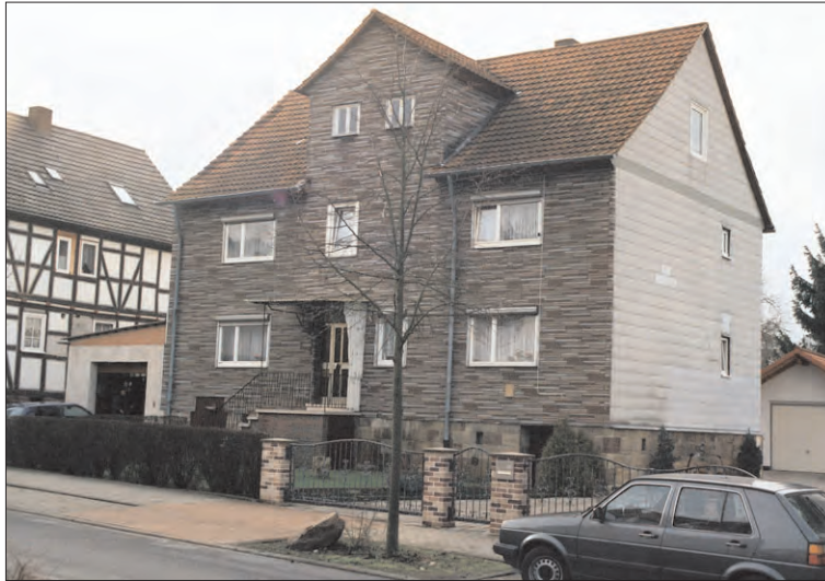
Verkleidung von Fachwerkfassaden mit Teerpappe : nicht förderfähig
