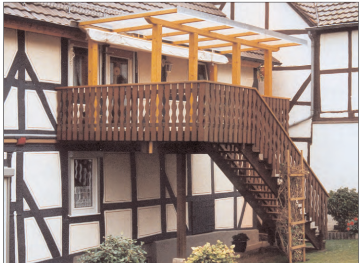
Der überdachte Balkon verdeckt mit seiner Massivität die Fassade und ist farblich nicht abgestimmt: nicht förderfähig
