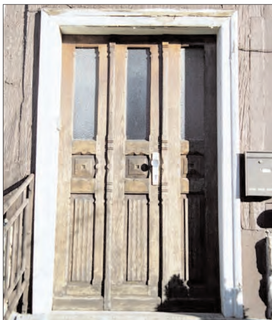
Erhaltung gestalterisch angemessener Holztüren: förderfähig
