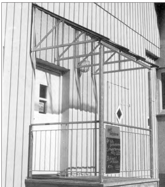
Überdachter Balkon mit filigraner Metallkonstruktion und zurückhaltender Gesamtwirkung: förderfähig
