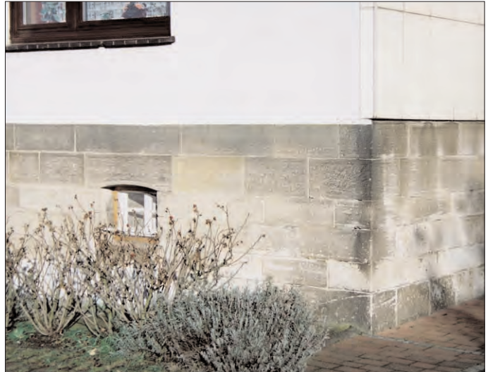
Quadermauerwerk erhalten und instandsetzen: förderfähig
