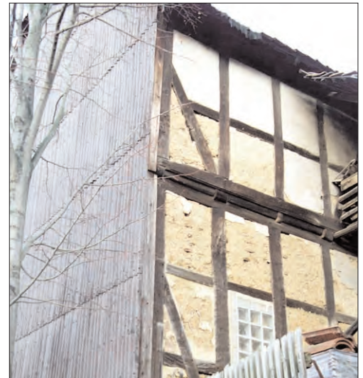
Fachgerechte Sanierung von Gefachen (z.B. Erhaltung der Lehmstakung an Kulturdenkmälern: förderfähig )
