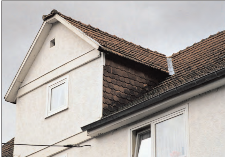
Dacheindeckung mit naturroten Tonziegeln: förderfähig
