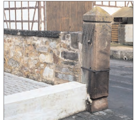
Bruchsteinmauer als Hofeinfassung mit Krone aus Sandsteinquadern: förderfähig
