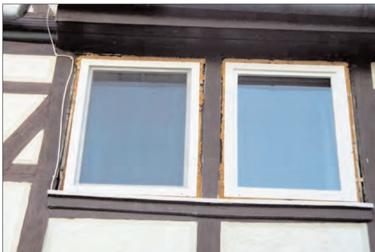
Auschäumung und Strukturputz: nicht förderfähig
