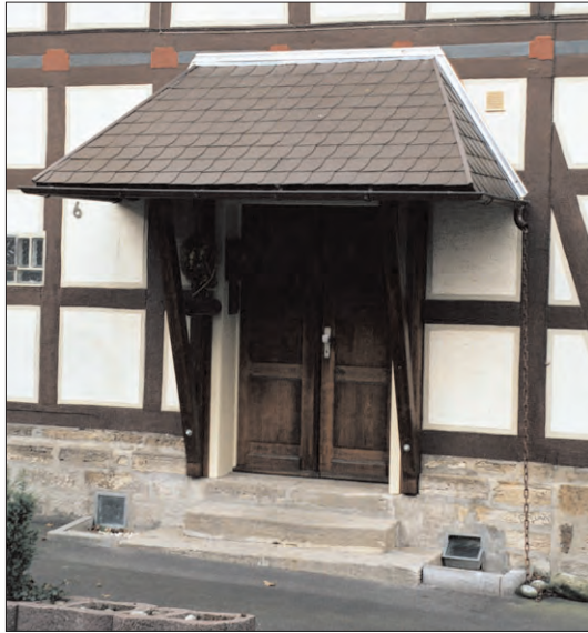
Links Dunkelbraune Faserzementschindeln und blanke Metall- schienen dominieren vor der Fachwerk- konstruktion: nicht förderfähig
