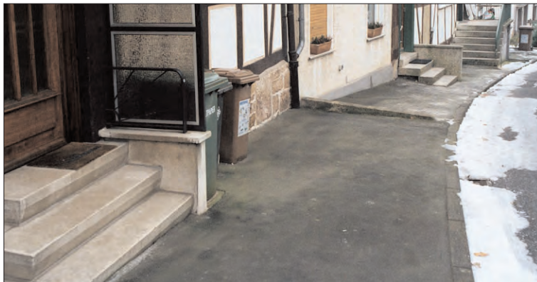
Asphaltierung kleiner Vorflächen: nicht förderfähig
