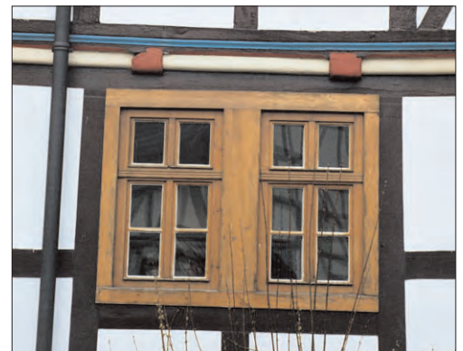
Neue Holzfenster als Verbundfenster, angemessen geteilt und in die Konstruktion eingebunden: förderfähig
