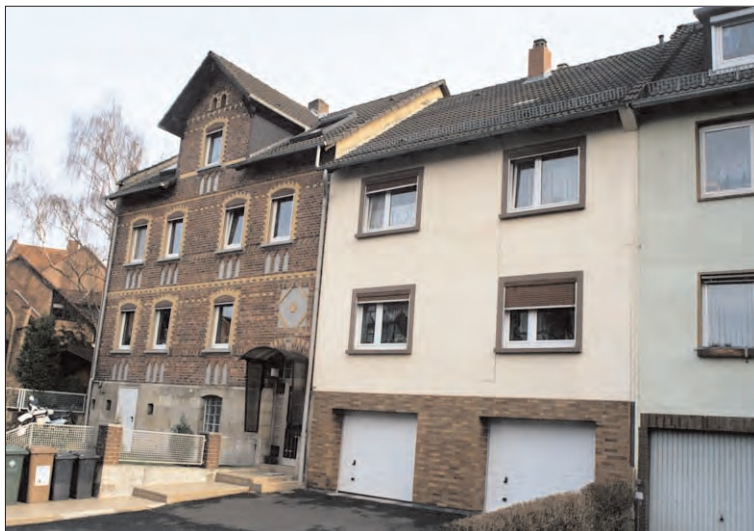
Dacheindeckung mit schwarzen Betonziegeln: nicht förderfähig
