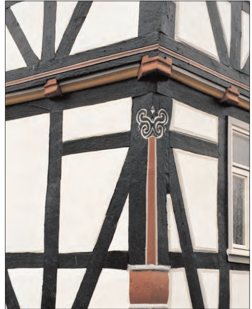
Rechts Gefache kalkweiß abgetönt, Details farblich dezent abgestimmt: empfehlenswert
