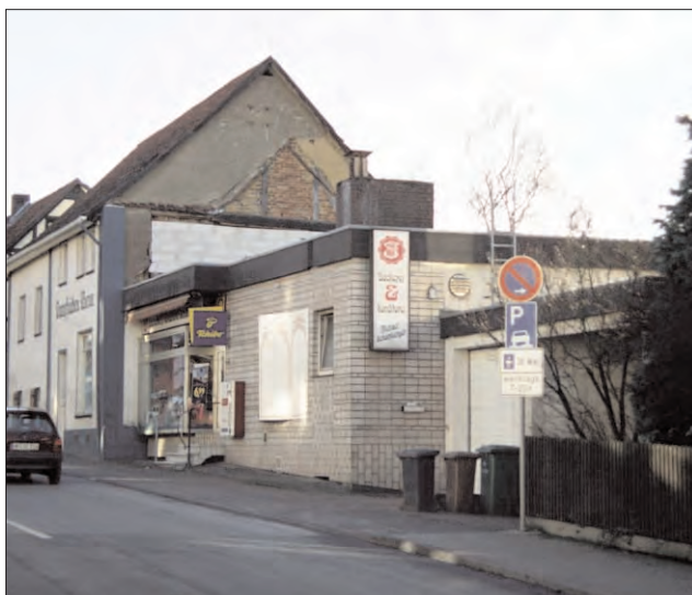
Flachdach rechts: nicht förderfähig
