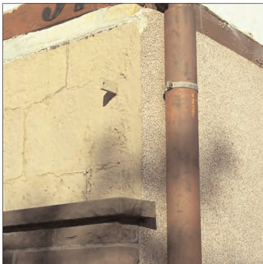
Sockel streichen, verputzen und mit bruchrauhem roten Sandstein verkleiden: nicht förderfähig
