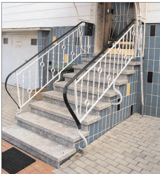
Trittstufen aus Kunststein, verklinkerte Sandsteinwangen: nicht förderfähig
