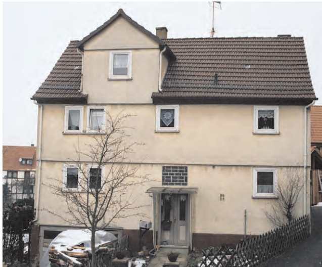
Verputz von Sichtfachwerk-Fassaden: nicht förderfähig
