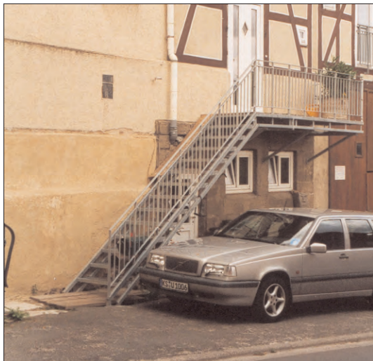
Anbau einer Metalltreppe mit hölzernen Trittstufen und filigranem Geländer: förderfähig
