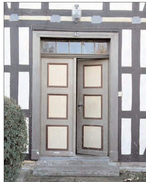
Fachgerechte Instandsetzung historischer Türen: förderfähig
