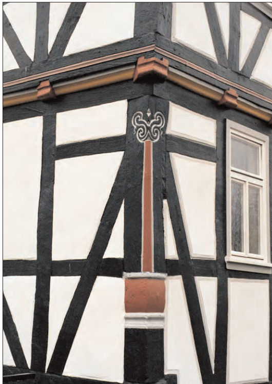
Fachgerechte Instandsetzung von Sichtfachwerk-Fassaden: förderfähig
