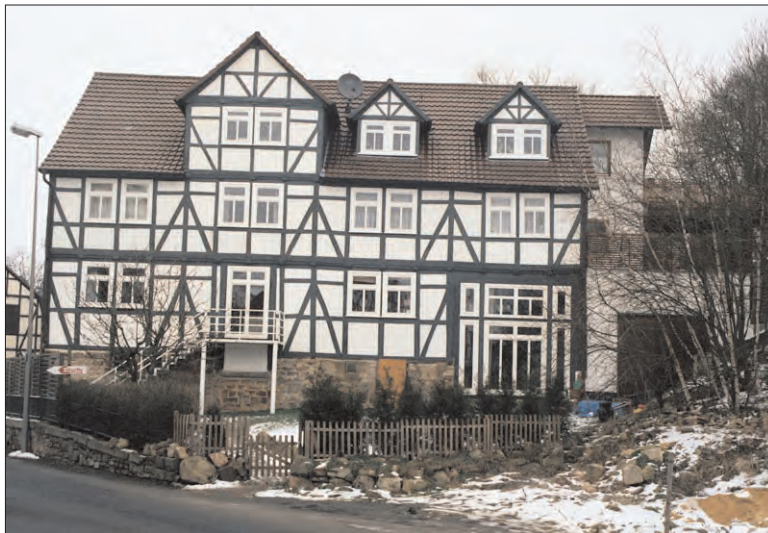
Beibehaltung der historischen Fassadengliederung: förderfähig
