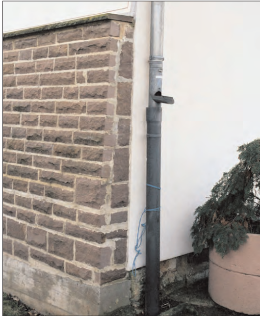
Sockel verputzen bzw. mit bruchrauhem und kleinformatigem roten Sandstein verkleiden: nicht förderfähig
