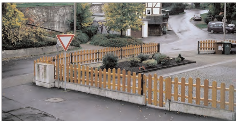
Holzzaun mit Brettern statt Staketen: nicht förderfähig
