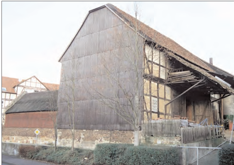
Verkleidung von Fachwerkfassaden mit Wellasbest-Platten: nicht förderfähig
