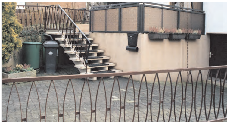
Metallgitterzäune auf Beton-Sockelmauer: nicht förderfähig
