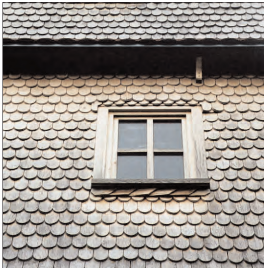
Verkleidung von Wetterseiten mit Holzschindeln: förderfähig
