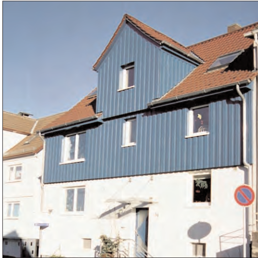
Teilverkleidung mit farblich abgestimmter senkrechter Holzschalung: förderfähig
