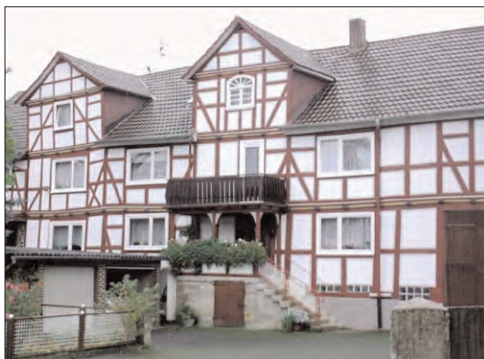
Balkon in Kombination mit Eingangsüberdachung, Dimension und Konstruktion auf die Fassade abgestimmt: förderfähig
