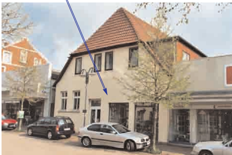
Mindener Straße Veränderungen eines Ensembles: die einheitliche Wirkung der Gebäude wurde durch Abbrüche und Neubauten mit Flachdächern zunichte gemacht.
