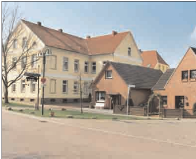
Schlossfreiheit: die größten und kleinsten historischen Gebäude direkt nebeneinander
