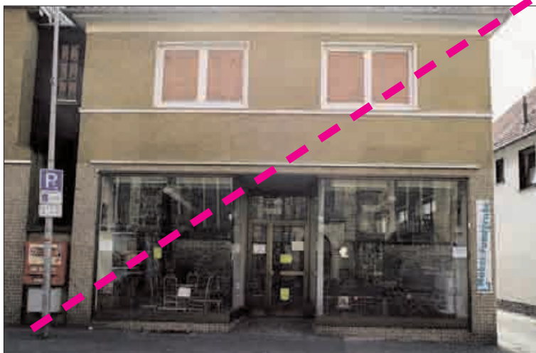
Die zu großflächige Verglasung entspricht nicht dem Charakter der Lochfassade.
