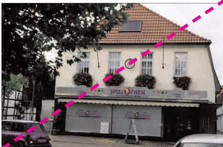
Die Reihung großer Glasflächen negiert die ursprüngliche Fassadengliederung.
